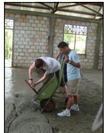
Stephen pouring cement
